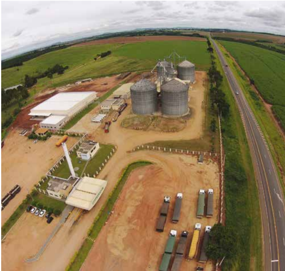
Gigante: silo e unidade insumos estão situados às margens da rodovia SP-215
