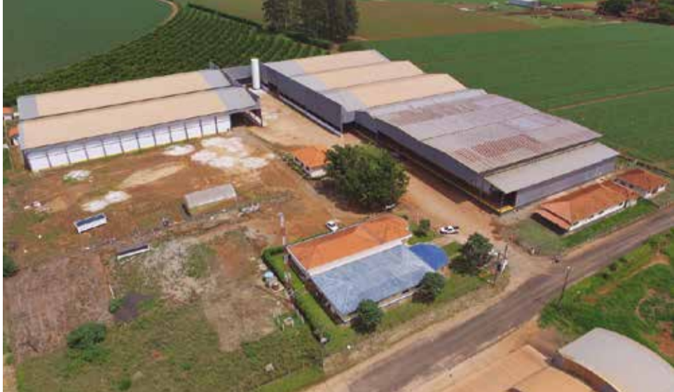
Megaestrutura: Complexo Frigorífico é capaz de armazenar o total de 344.560 caixas
