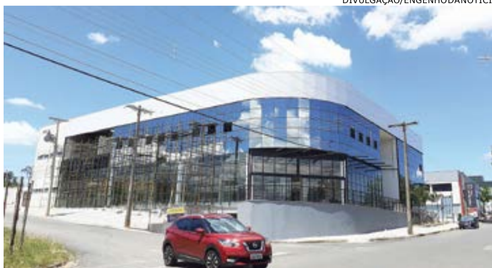
Com 505 m 2 , nova agência será na rua Dr. João Batista Figueiredo Costa, 553
