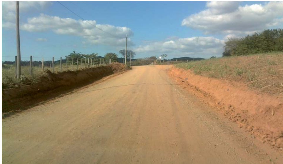
Estrada de acesso a Fazenda Bom Jardim, via Santa Lúcia pela SP-350, está recuperada
