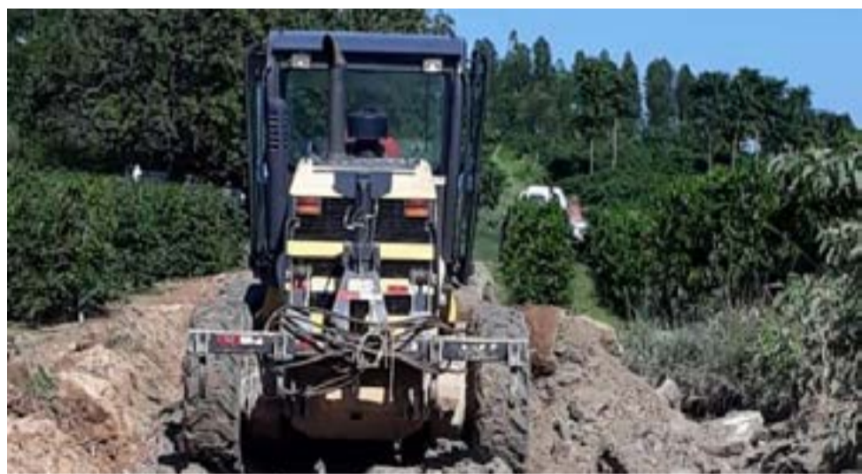
Prefeitura realizou recentemente melhorias na Estrada Perobinha
