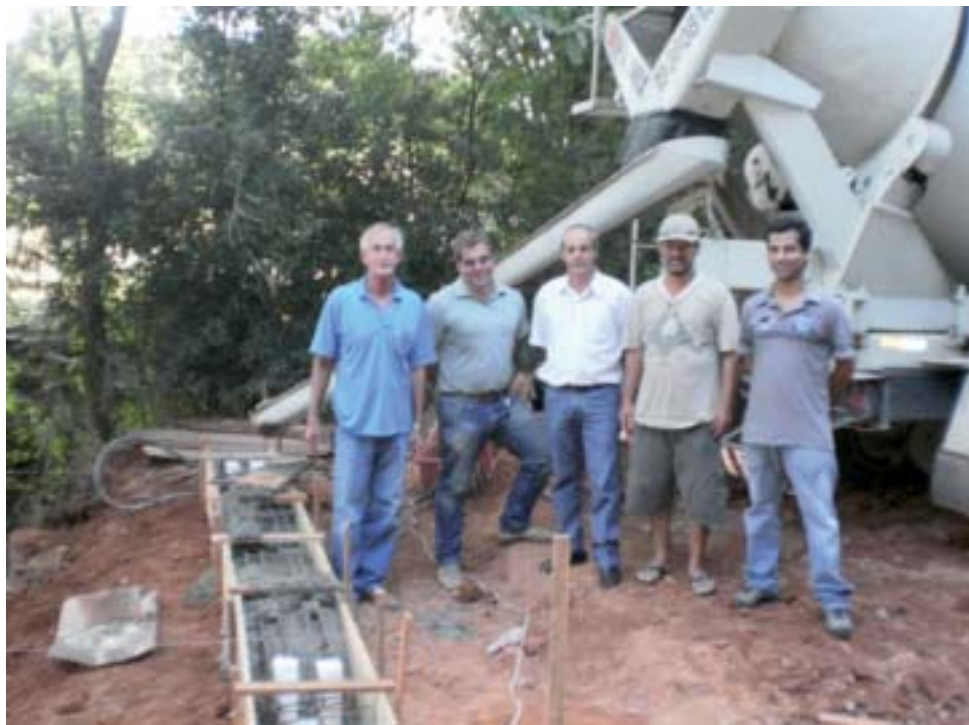
Vice prefeito Padoca, engenheiro Luciano, prefeito Ico e os vereadores Ismar e Fernando no início de reconstrução da ponte no Bairro Contendas
