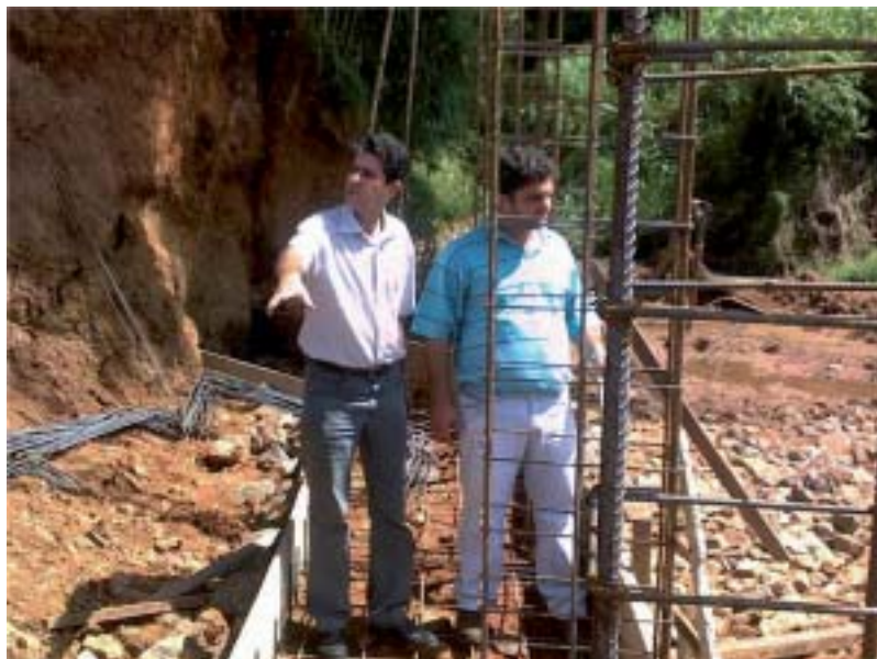
Prefeito João Luís Cunha e Marco Aurélio Feltran têm vistoriado as obras realizadas na cidade
