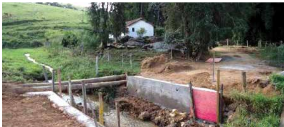
Prefeitura tem recuperado pontes na zona rural
