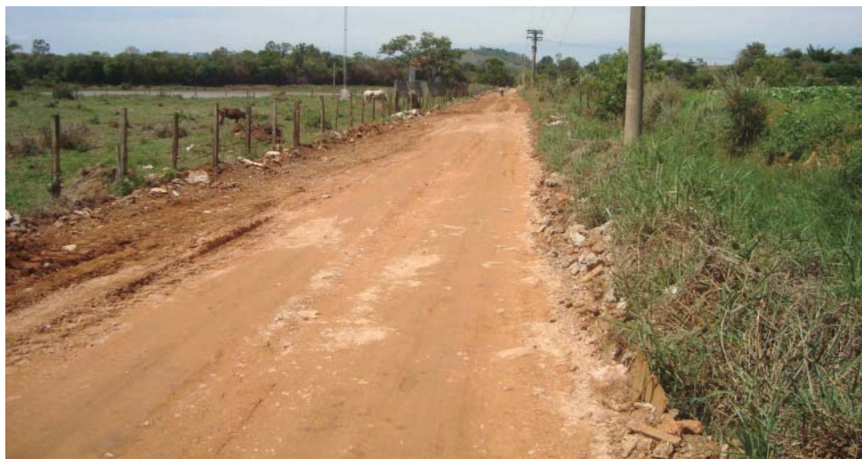
Prefeitura acumulou entulho na estrada para formação de base para a obra de elevação do leito num trecho de 500 metros
