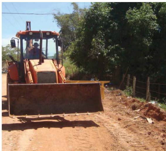
Prefeitura acumulou entulho na estrada para formação de base para a obra de elevação do leito num trecho de 500 metros
